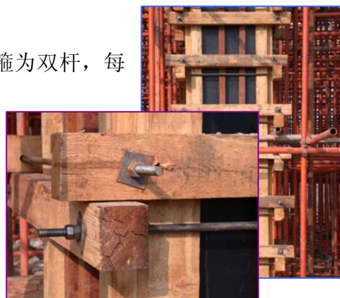
图 12-2 框架柱方形柱模板
