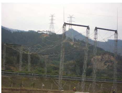
图 16 绝缘绳及绝缘网应用实例
