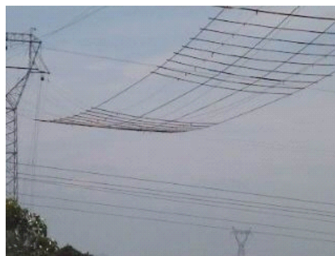
图 16 绝缘绳及绝缘网应用实例
