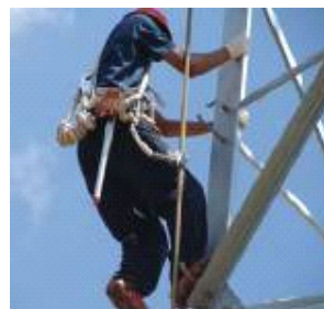
图 9 绳索式自锁器应用实示例图
