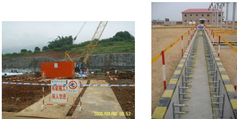
图 41 现场围护示例图
